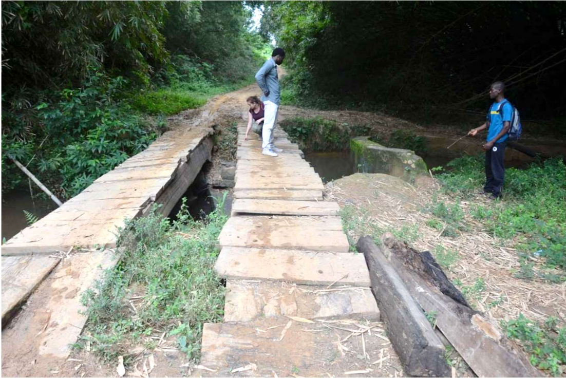
Abbildung 7: Besichtigung einer neu gebauten Brücke
