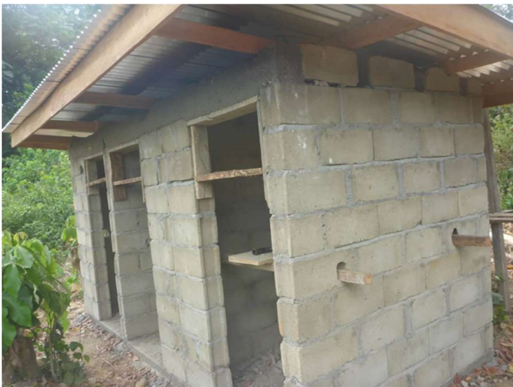
Abbildung 17: Bau der Schultoilette
